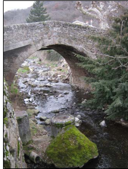
Figure 3-8 : Le Crémieux au niveau du pont de Peyraud
