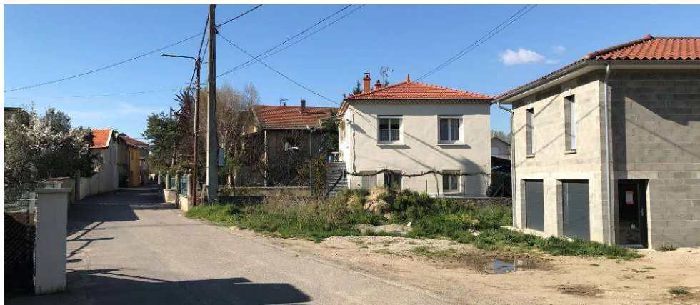
Deux logements en dent creuse en construction – photo mosaïque environnement
