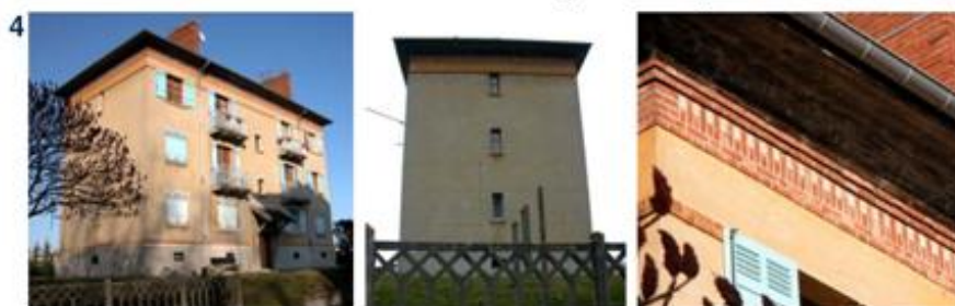
4 Logements collectifs des années 1930 , pour les employés de la SNCF
