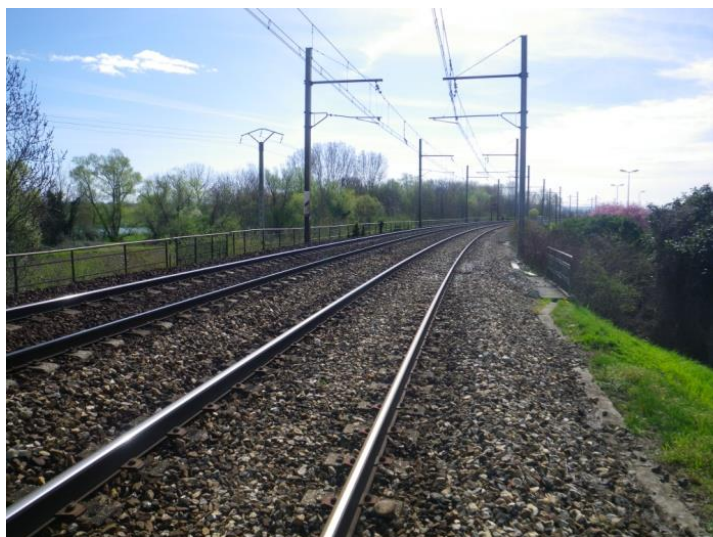
Photo n°25. Voie ferrée non grillagée au Nord de la commune (source : Mosaïque Environnement)
